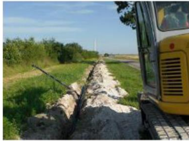
Photo 23 : Pose de câbles électriques et réalisation de tranchée à la pelle mécanique (Source : BE Jacquel et Cbatillon)
